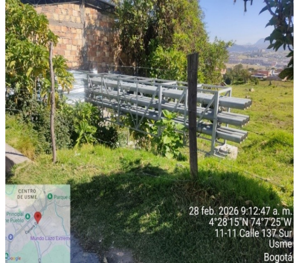
Fotografía No. 8. Panorámica de área de intervención de la quebrada La Taza y la proyección de redes de parqueadero de ENEL X.
