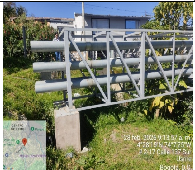
Fotografía No. 6. Estructura de cercha con micropilote.
