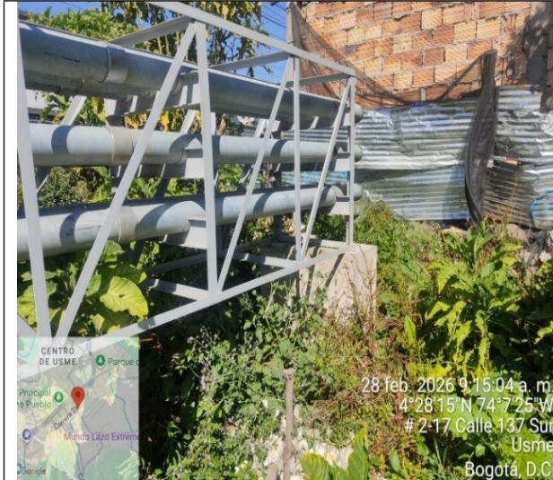
Fotografía No. 3. Panorámica de área de intervención quebrada La Taza – Costado oriental.
